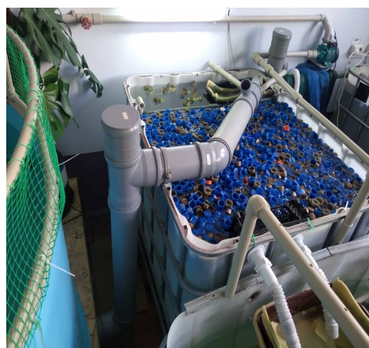
Рисунок 2 Система сброса оборотной воды из бассейнов с рыбой на очистку в цехе выращивания товарной рыбы
